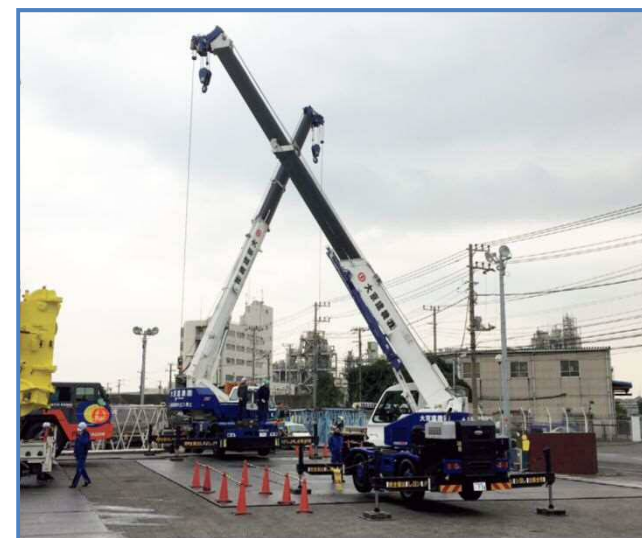
【クレーン実機風景】
